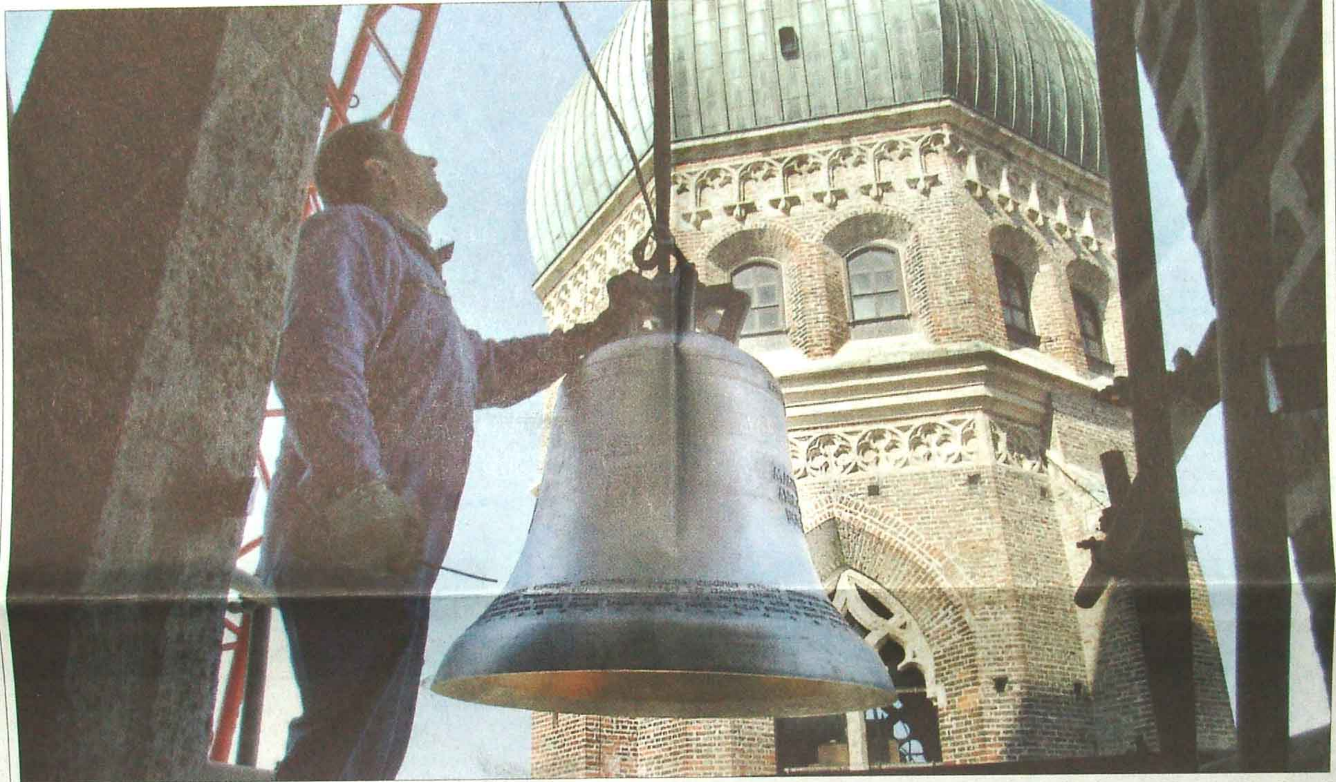
Oben angekommen: In der Glockenstube wird die erste der neuen Glocken von Spezialisten in Empfang genommen. Montiert wird heute erst. Foto: Stephan Rumpf
