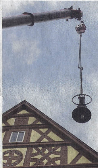
Ein großer Kran hievt die beiden Glocken nacheinander hinauf in die Laterne der Annakapelle.
