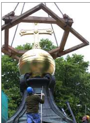
Vorsichtig wird die Traverse, die als Befestigung für den Transport in die Lüfte dient, über das Kreuz dirigiert.
