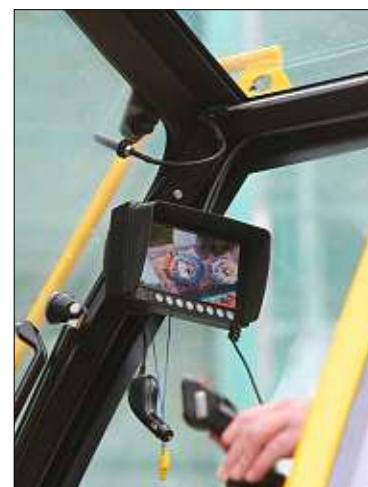
Mit Hilfe einer Videokamera kann der Kranführer die Turmhaube zentimetergenau platzieren.
