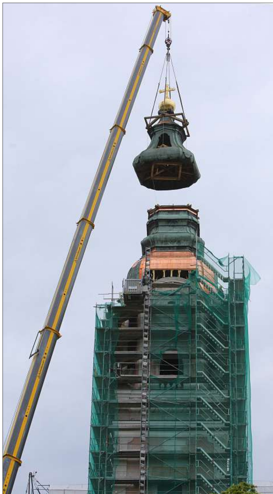
Die letzten Meter , dann ist es geschafft: Kurz vor zwölf Uhr schwebt die Turmspitze mit vergoldeter Kugel und Kreuz ein.
